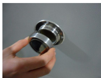
测试孔遮盖物（不锈钢盖）
